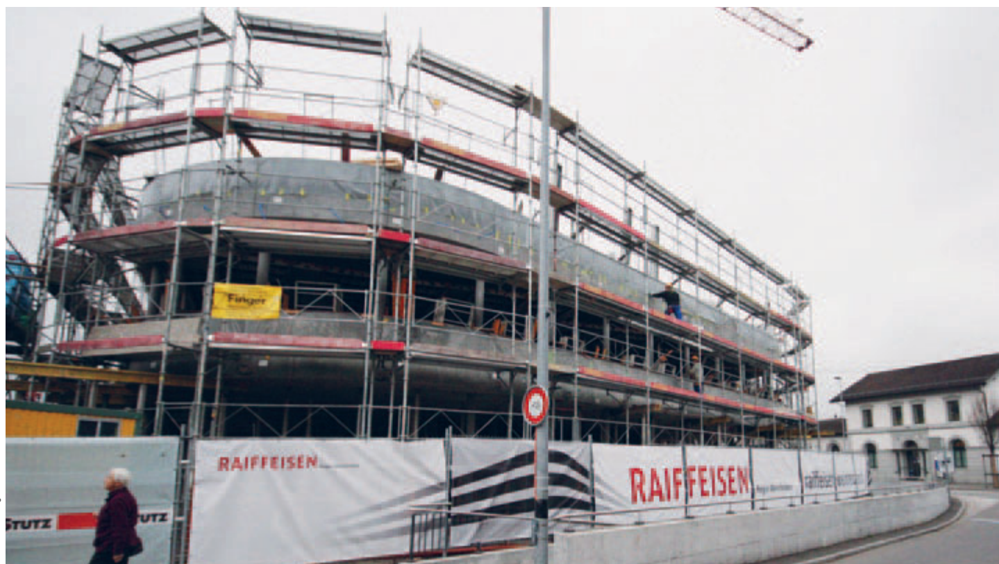
Raiffeisen bietet nicht nur Baufinanzierungen an, sondern baut auch selber kräftig. Im Zentrum von Weinfelden entsteht ein neues Raiffeisengebäude.
