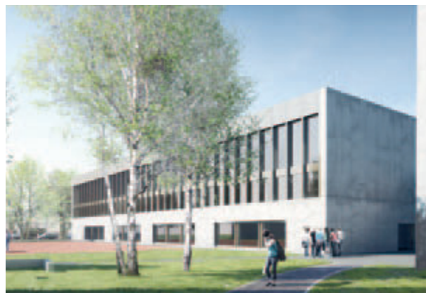
Turnhalle Weinfelden, Aussenansicht.
